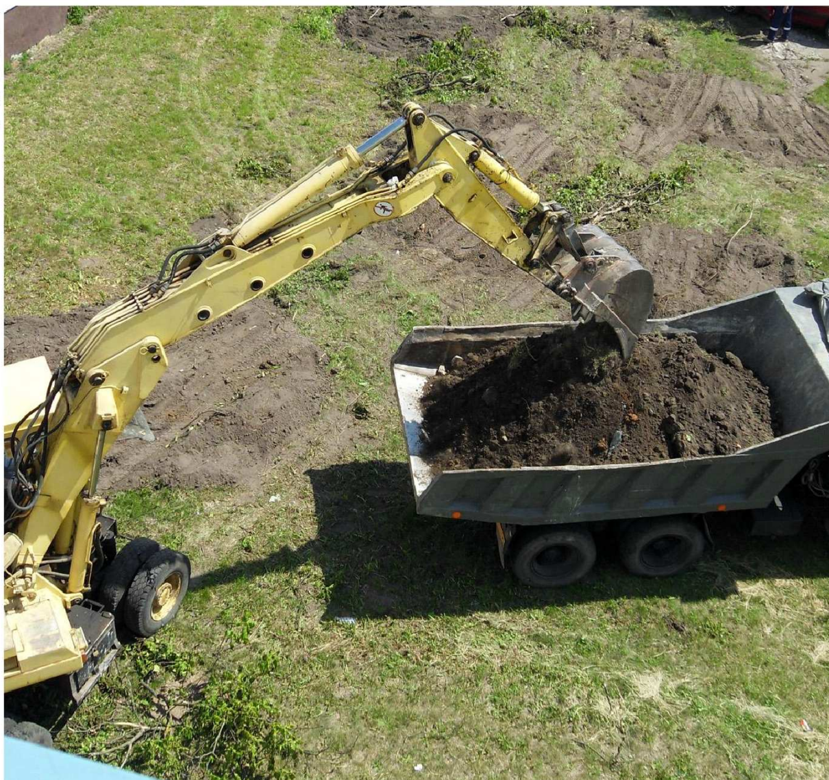
Koparki ładujące ziemię na ciężarówki robią niezły hałas, który uniemożliwia normalną pracę.
