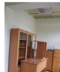
Szkoła BeSz podczas remontu
